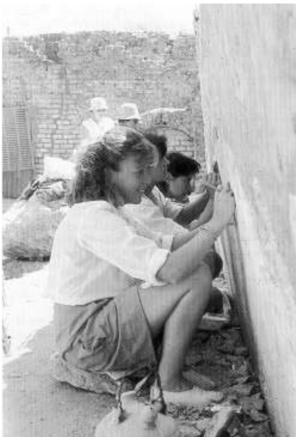
6.- Restauración de las pinturas murales del criptopórtico de la Casa de la Exedra en Itálica.
