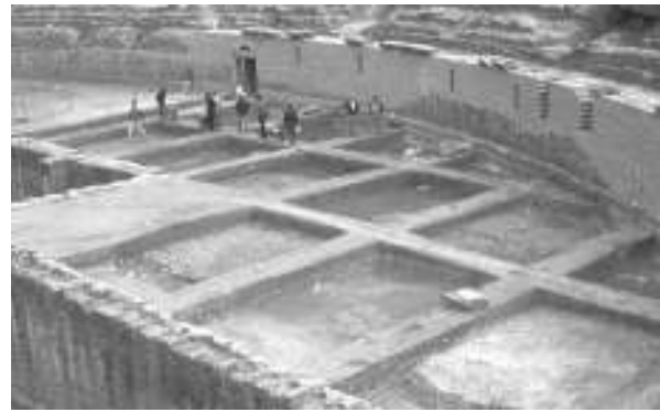
3.- Excavación en la arena del anfiteatro de Itálica, mediante el método de cuadrículas, dejando muros testigos.
