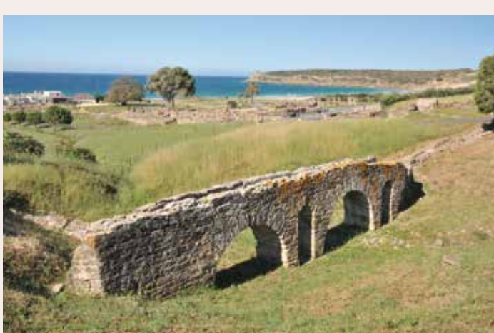
View of the Punta Paloma aqueduct
