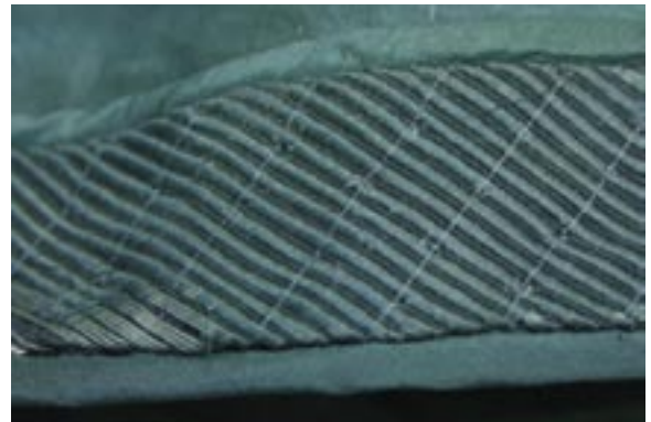
MACPSDJ05696. Fijación con punto de restauración.
